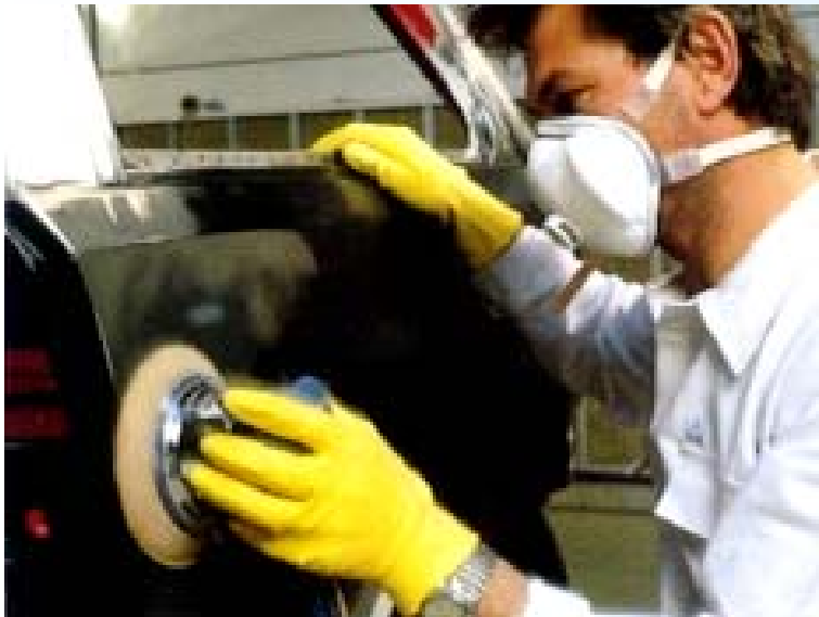
Сухая шлифовка с ПЫЛЕОТВОДОМ
